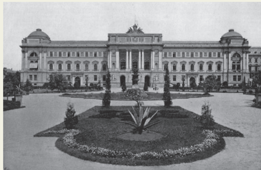
Budova Zemského snemu vo Lvove, arch. Wikimedia Commons
